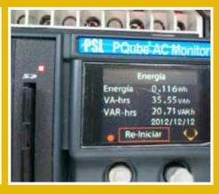
Con la instalación de estos equipos, es posible recibir información de parámetros de calidad de energía, teniendo capacidad para registrar los parámetros de tiempo y duración de interrupciones, variaciones y distorsiones en la calidad de energía de las redes de distribución, entre otros, obteniendo la información vía mail interno y siendo posible la interrogación del equipo en cualquier momento y así obtener datos reales de las condiciones de la red en donde se encuentra instalado el mismo.
