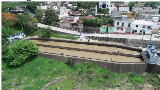
Imagen No. 5 – Primer desarenador.
