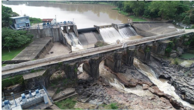
Imagen No. 2 – Presa Los Esclavos y puente colonial.
