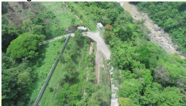
Imagen No. 4 – Canal de conducción.
