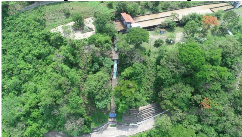
Imagen No. 7 – Cámara de carga.
