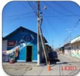
Instalacion de equipo PQube en el area de conexion de la lampara a la red de Distribucion de BT.
